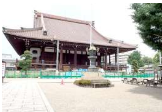
大念佛寺は令和の大改修で、 本堂の屋根は銅で葺かれたばかり 250622 撮影 柗元慶子
