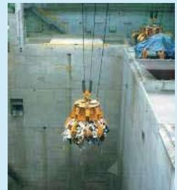
ごみ収集車からピットへごみを落として、一回に多くのごみをクレーンでつかみ、炉の中に運ぶ。
