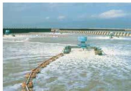
よごれた水をきれいにする機械(エアレーター) 水に空気をまぜることによって、び生物(※)をふやし、水の中の害になるものをたばさせてきれいにするしくみ
