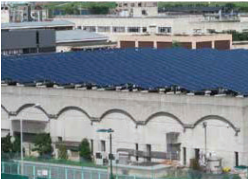
くじま 柴島じょう水場 合計400キロワットの発電せつびを設置しています。
