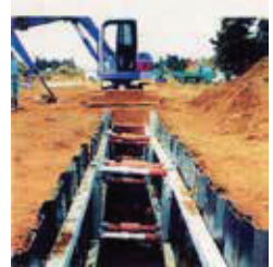
下水管工事にスラグを使う (建設ざいりょう)
