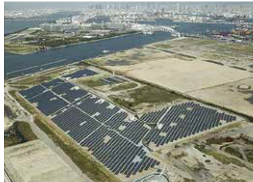
ゆめしま 夢洲のメガソーラー 10,000キロワット（約3,200けん分の家の電力消費量）の発電せつびを設置しています。
