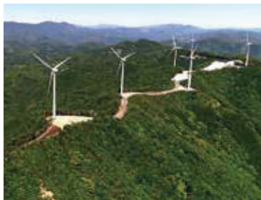
プロペラ型風力発電 (和歌山県印南町・みなべ町)
