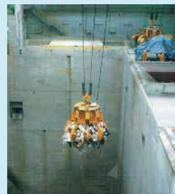
ごみ収集車からピットへごみを落として、一回に多くのごみをクレーンでつかみ、炉の中に運ぶ。
