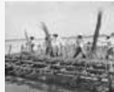
水制をつくっているようす 昭和初期
