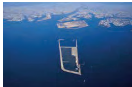
大阪沖処分場(令和2年12月10日撮影)
