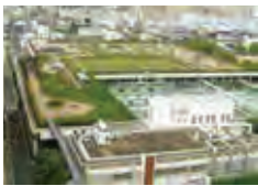
放出下水しより場
