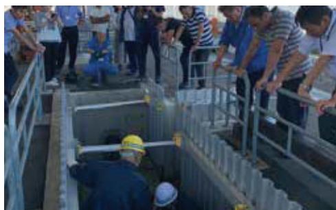
(2) 都市上水道維持管理コース： 体験型研修センターにおいて、漏水している水道管の修理方法等を学びます。
