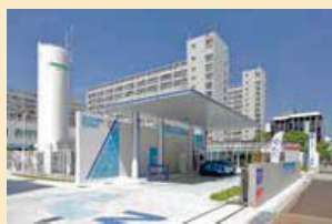
燃料電池自動車用水素ステーション (城東区)
