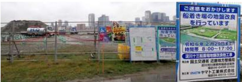
摘み草苑のあった場所は、船着き場の工事のため閉鎖されていた ウォータースポーツや飲食のできるスペースとして、整備予定 かつての園芸品種の花畑の様相は残っていない 240225 撮影 柗元慶子
