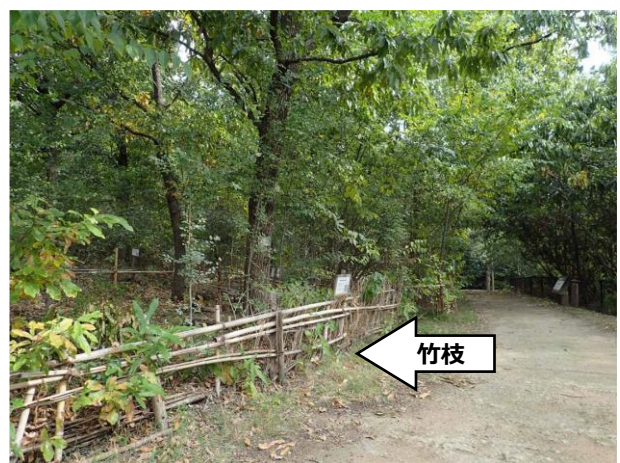
外周路部分は落葉シーズン前に落葉止めの補修が必要 竹枝組みが間に合わない部分には竹竿を置くなどの対策か
