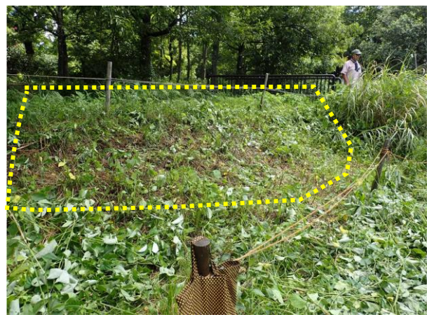
水路側法面 カラムシ作業後
