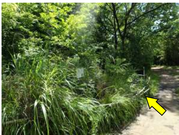
実生創生ゾーン柵補修前 竹柵が通路側に倒れ落ちそうになっていた
