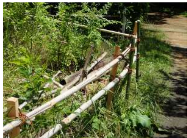
実生創生ゾーン柵新規作製 新しい木の杭を打って、紐もくりなおした
