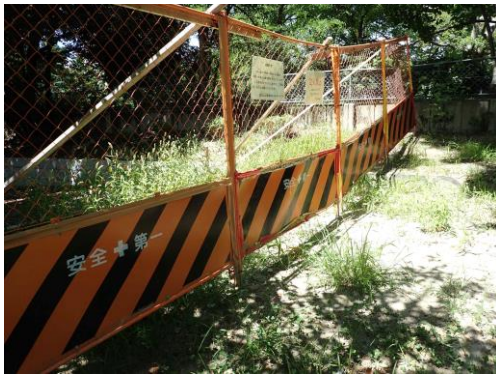
宰相山公園（三光神社）は、南半分が、階段の 上、下ともに工事中で立ち入り禁止だった。
