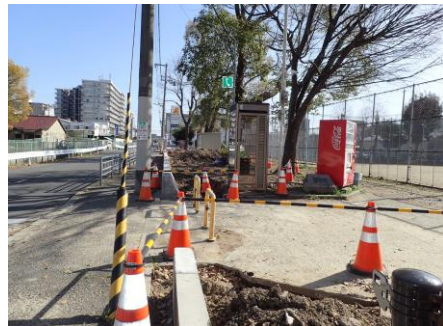
加美末次公園西の歩道部では、大きな街路樹の植 え替えと思われる整備工事が行われていた 220327 撮影 柗元慶子
