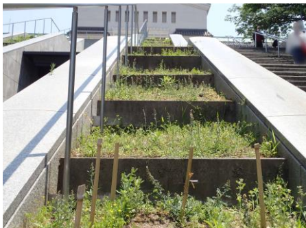
天王寺美術館正面階段の植栽樹 220522 撮影 柊元慶子
