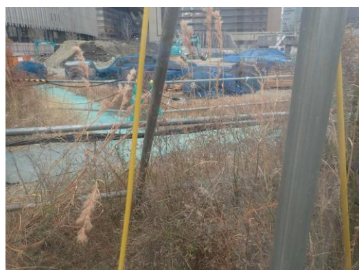
グランフロント 2 期工事のフェンスの中 220123 撮影 柊元慶子
