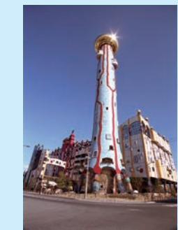
ごみ発電を行っている 舞洲工場
