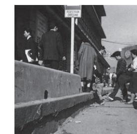
地盤沈下のようす
