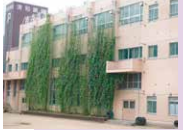
西区 九条東小学校
