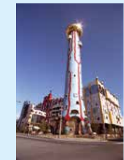
ごみ発電を行っている 舞洲工場
