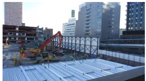
イオン京橋店が解体されていた。若い頃はダイエーとして親しんでいたスーパーだが、ちょっと寂しい。
