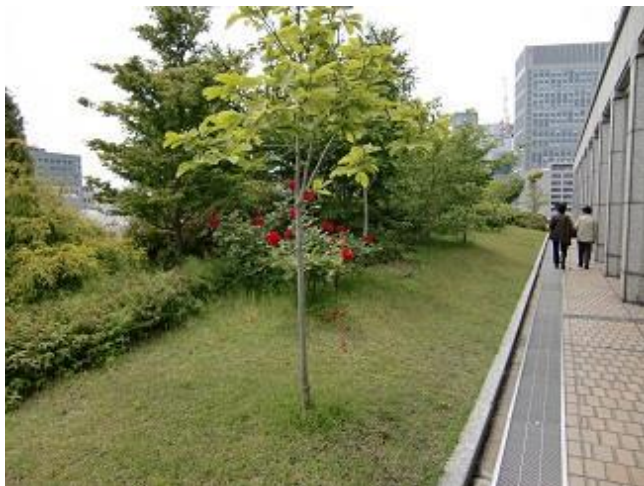
大阪市役所 屋上緑化
