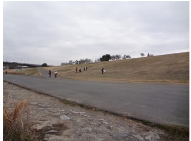
淀川左岸堤防 150315 撮影:北川ちえこ
