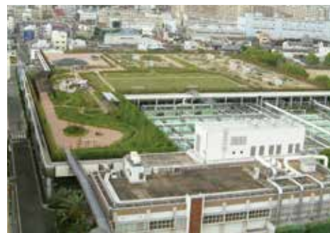
放出下水しより場
