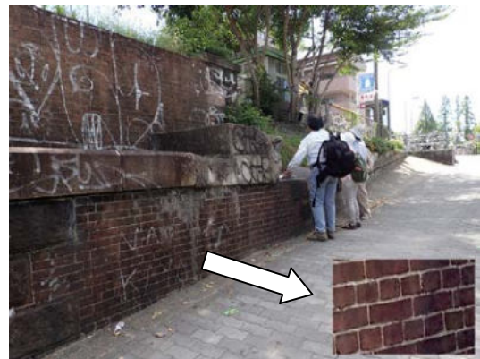
淀川(大川)橋梁煉瓦橋台南側 イギリス積み 160821 撮影 柊元慶子
