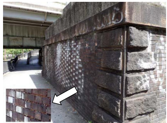
淀川(大川)橋梁 煉瓦橋台北側 フランス積み こちらが古い(明治中期) 160821 撮影 柊元慶子
