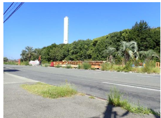
関西電力南港発電所(S62 着工)周囲は「エコロジー緑地」として混植・密植が施され、深い森を形成している 食品埠頭バス停から 190915 撮影 梶元慶子
