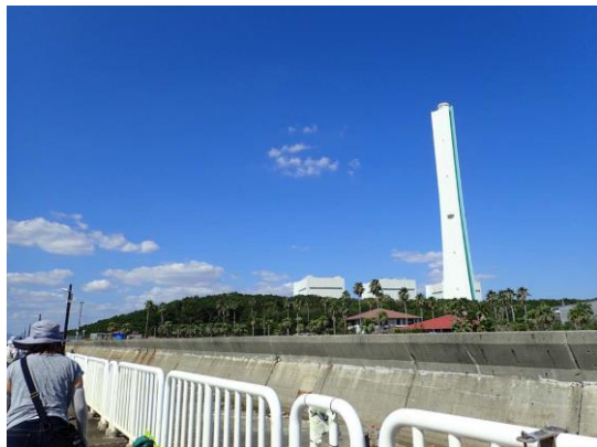
魚釣り護岸から見た南港発電所 190915 撮影 榎元慶子
