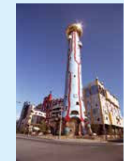
ごみ発電を行っている 舞洲工場
