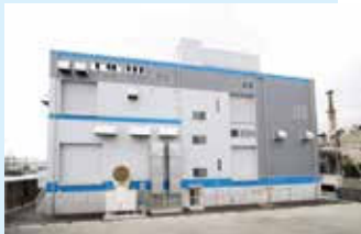
消化ガス発電を行っている 津守下水処理場
