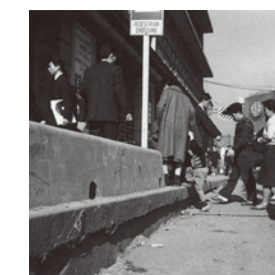
地盤沈下のようす
