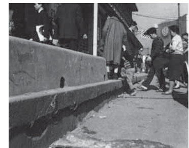
道路の地盤沈下 (1960年ごろの阪急梅田駅) (出典：写真で見る大阪市100年)
