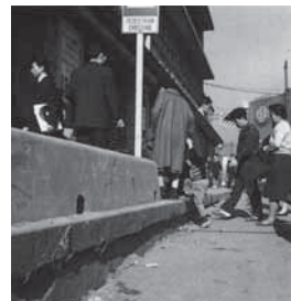
地盤沈下のようす
