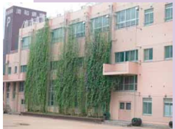
西区 九条東小学校
