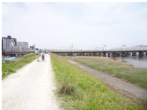
淀川左岸堤防 日陰はないが風が通る 下流方向 170521 撮影 北川ちえこ
