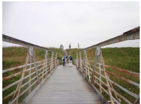
中津二之橋 170521 撮影 北川ちえこ
