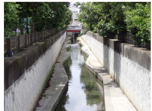
前回調査時は工事中だった場所 人工的にカーブがつけられていた 190519 撮影 梶元慶子
