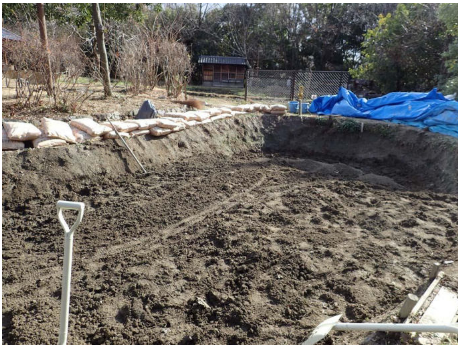
底面を耕起したところ 底面用にベントナイト50袋を運搬
